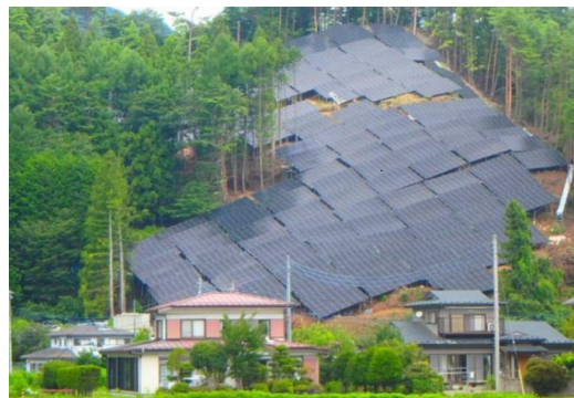
人家との間に残置森林が十分配置されていない事例（0.99haであり林地開発許可対象外）
