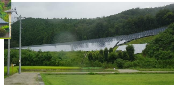
地域の景観を変えうる斜面一面のパネル（0.99haであり林地開発許可対象外）
